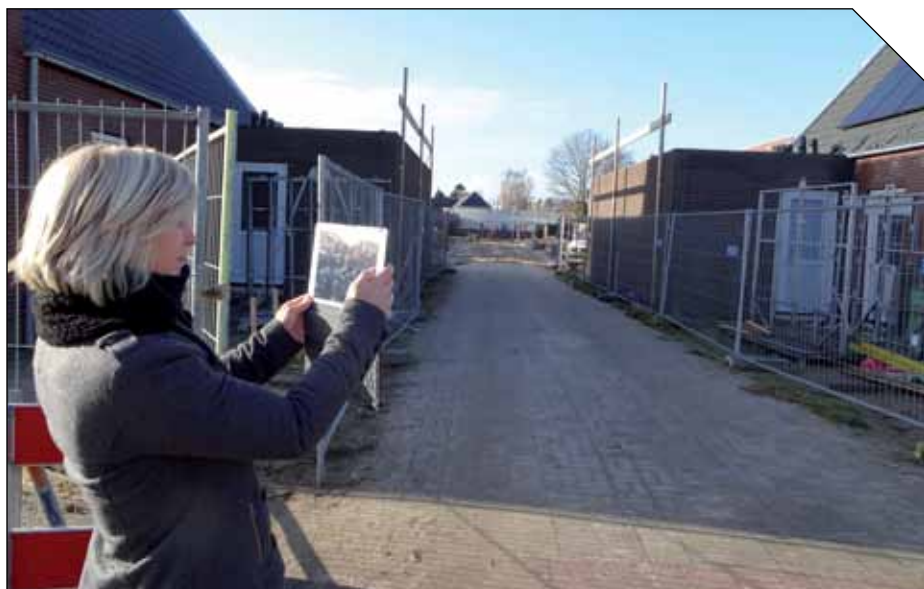
Woningen in aanbouw (WOZ-toepassing).
