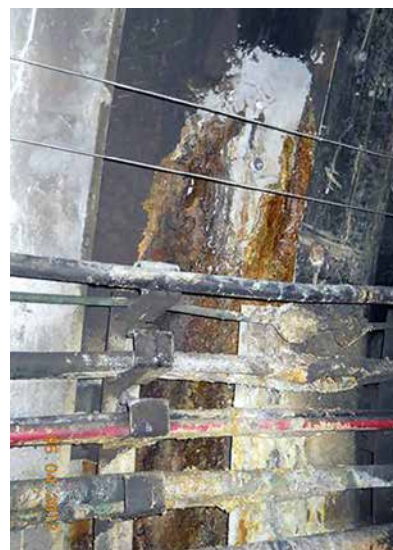
De originele tunnelbekleding uit de jaren 70 vertoonde sporen van waterlekkages waardoor onveilige situaties konden ontstaan.
