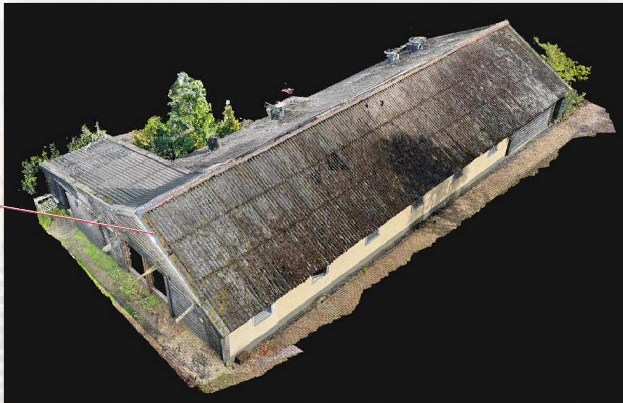
Stal 26x15 m1 ingemeten voor dakvervangning en zonnepanelen
