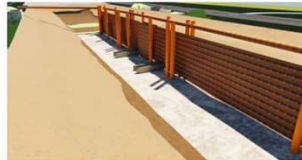
Step 4 - schoonmaken damwand, plaatsen betonbakken en storten onderwaterbeton
